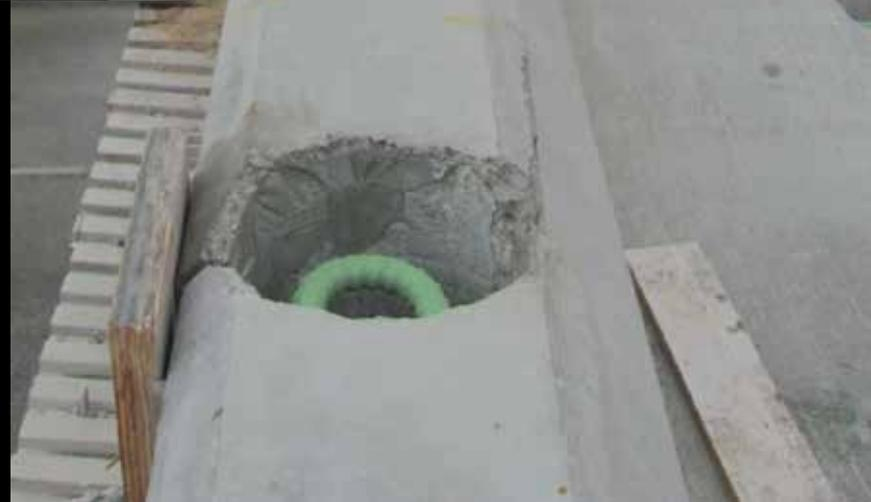
Shear Stud Blockout
